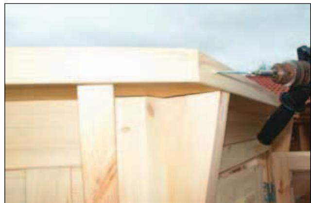
blende 4.1 bündig anschraubt. (Bild 10 und Zeichnung 6)
