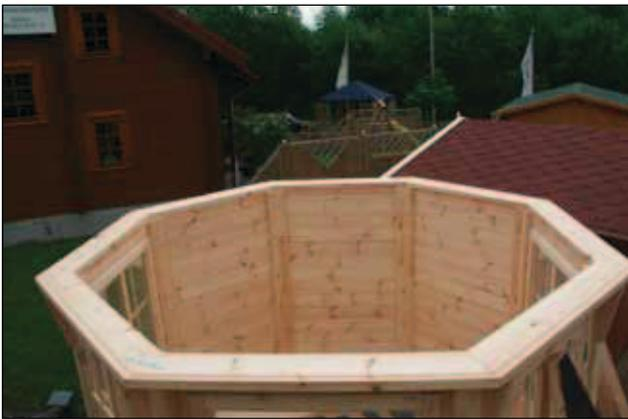
Die Eckständer (Bild 10 a, Zeichnung 6) werden nun an die Ecken des Pavillons geschraubt (Schraubengröße 5 x 80, Bild 10 b, Zeichnung 7).
