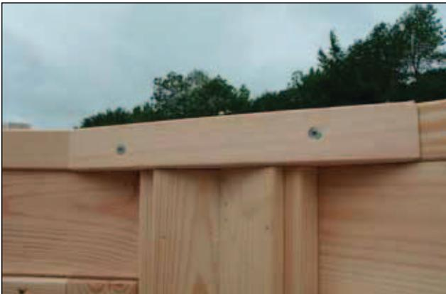
Gleichzeitig dienen die Eckständer auch als Auflage des Dachkranzes (Bild 11, Zeichnung 8).
