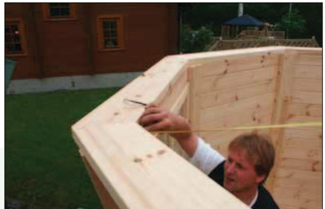
kranzes wird dieser mit dem Korpus verschraubt (Schraubengröße 5 x 80, Bild 11 b und Zeichnung 7), so daß alle Dachauflagebretter mit dem Korpus verbunden sind (Bild 12 und Zeichnung 9, Seite 9).
