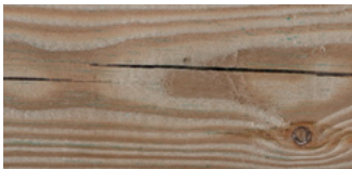
Spannungsrisse durch die Holz-trocknung
