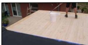
3. Die zurückgeschlagene Folie auf den mit Kleber eingestrichenen Teil ziehen und mit einem Besen von der Mitte des Daches aus die Folie glatt streichen, sodass die Falten beseitigt werden. Diese Arbeitsschritte mit der verbliebenen Folie wiederholen.
