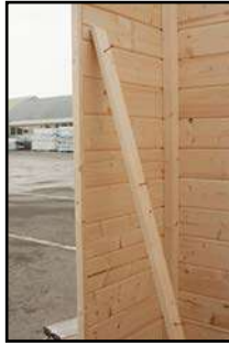
Bereitstellen der Türblindleisten
