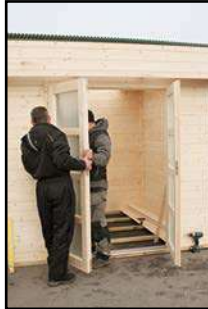
Einhängen der Türen und justieren
