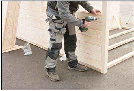
Montage weiterer Wandbohlen
