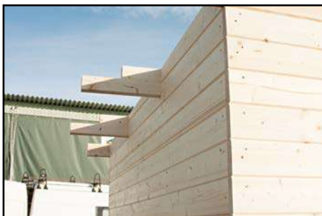
Dachsparren einlegen achten Sie auf technische Daten
