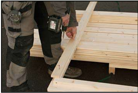
Verschrauben von dem Türrahmen
