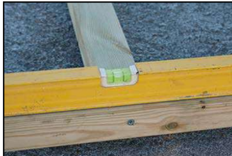
Kontrolle ob Fundamenthölzer in Waage
