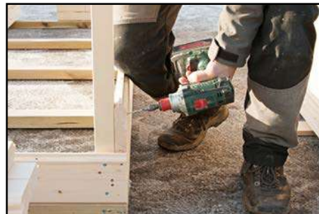
2. Bohlenkranz montieren
