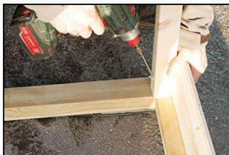
Eckkantholz am Fundament verschrauben
