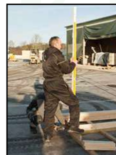
Eckkantholz in Waage ausrichten
