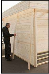
Abdeckleisten anbringen laut technischen Daten
