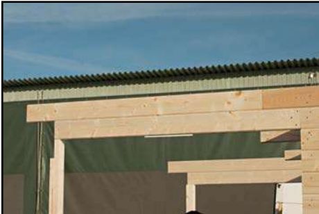
Vorder- und Hinterseite Anbau
