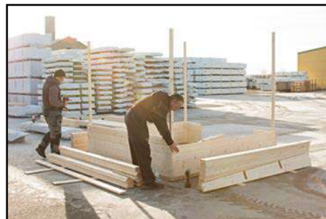
Anbringen der gesamten Wandbohlen
