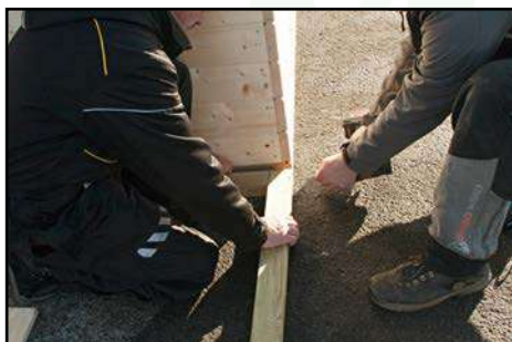
Verschrauben der Fundamenthölzer
