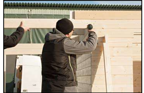
Montage der Wandverlängerung (vorne) nach technischen Daten
