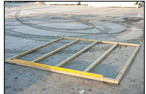
Kontrolle ob Fundamenthölzer in Waage
