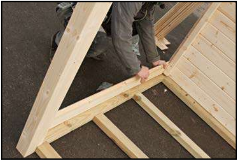
1. Wandbohle in Waage ausrichten
