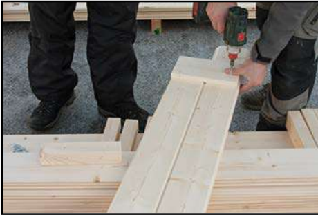
Verschrauben der Wandverlängerung
