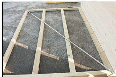
Diagonale vom Fundament kontrollieren
