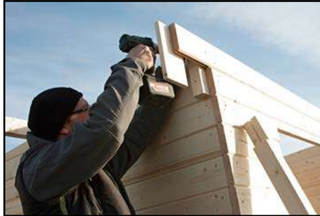
Montage der Wandverlängerung (vorne) nach technischen Daten
