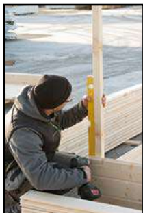
Kontrolle mit Wasserwaage ob im Lot
