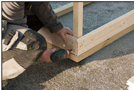
Verschrauben der Wandbohlen an den Eckkanthölzern
