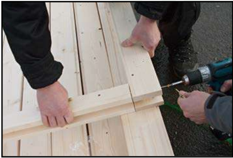
Verschrauben von dem Türrahmen
