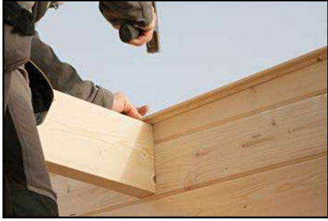
Anbringen der Dachbretter laut technischen Daten
