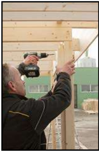
Anschrauben der Führungsleiste für Geschlossene Wand
