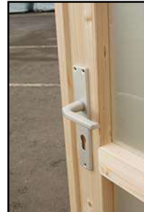
Anbringen der Drückergarnitur und Zylinderschloss
