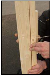
Anschrauben der Führungsleiste laut technische Daten
