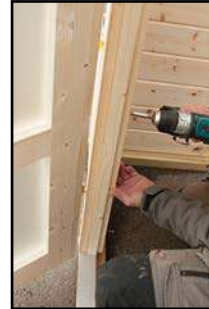
Befestigen vom Türrahmen mit den Türblindleisten innen
