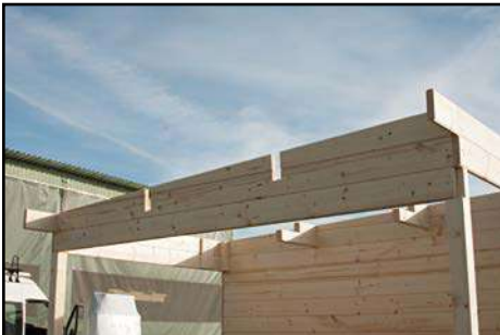
Seitenwand Montage Anbau
