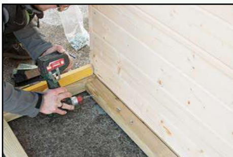
Kontrolle ob das Fundament in Waage liegt
