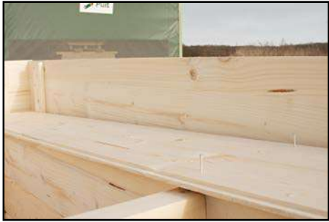
Auflegen der Dachbretter
