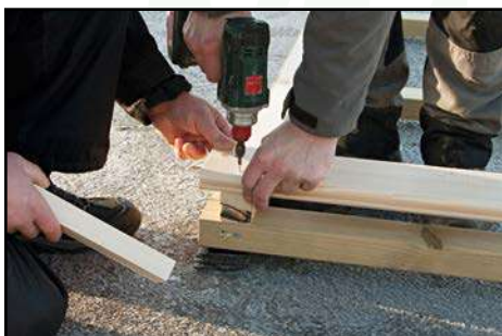
1. Wandbohle am Eckkantholz vorbohren und verschrauben
