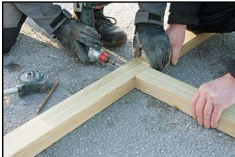
Fundamenthölzer verschrauben
