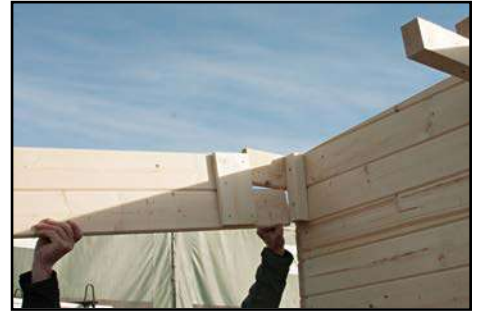
Montage der Wandverlängerung (hinten) nach technischen Daten
