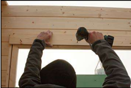
Befestigen vom Türrahmen mit den Türblindleisten aussen
