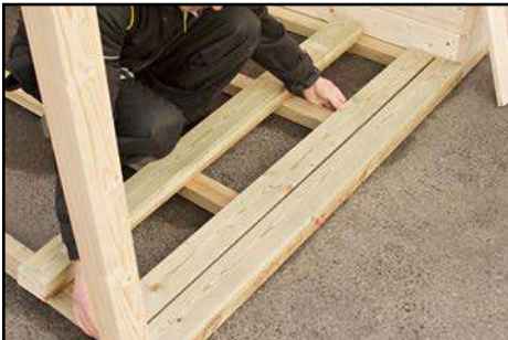
Verlegen und befestigen der Terrassenbretter
