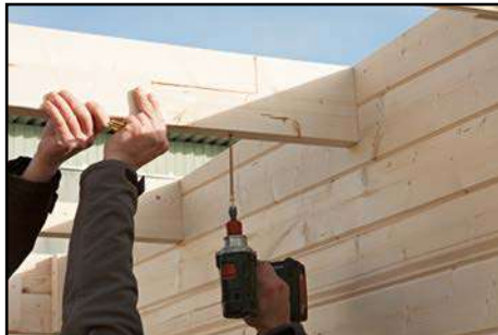
Auflegen und befestigen der Dachsparren
