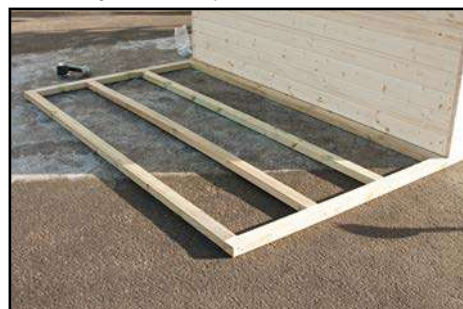
Auslegen von den Fundamenthölzern
