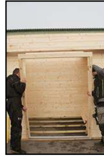
Einbau vom Türrahmen
