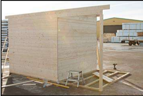
Montage Stützpfosten
