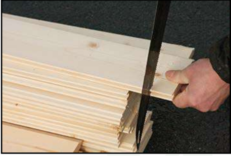
Dachbretter zuschneiden laut technischen Daten
