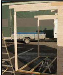
Vorder- und Hinterseite Anbau
