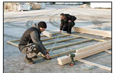
Diagonale vom Fundament kontrollieren
