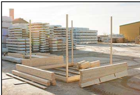
Vorbereiten der passenden Wandbohlen
