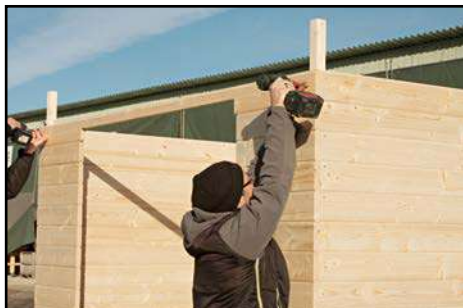
Anbringen der oberen Wandbohle (Tür)
