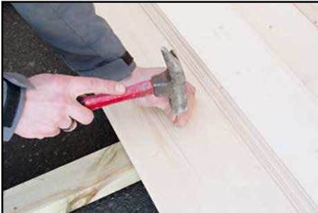
Fußboden im Haus einbringen und befestigen
