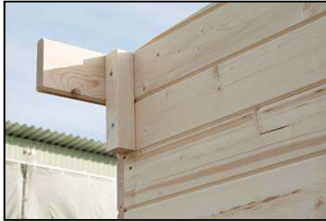
Montage der Wandverlängerung (hinten) nach technischen Daten
