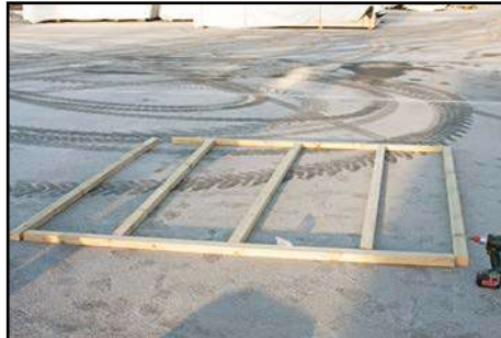
Fundamenthölzer auf gerades Fundament legen
