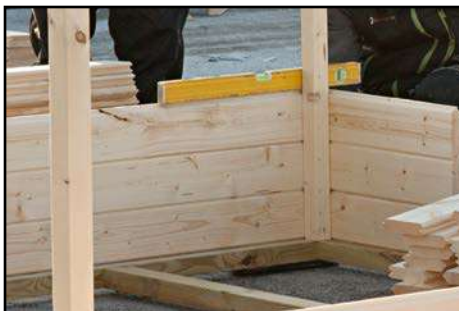
Kontrolle mit Wasserwaage ob in Waage
