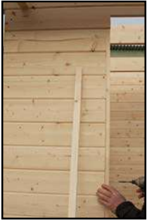
Türleisten anbringen laut technischen Daten
