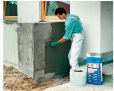
Mit dem schnell härtenden Betonspachtel PCI Polycret 5 können normal saugende Betonflächen ohne Grundierung in einem Arbeitsgang überspachtelt werden.
