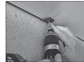
Leistenclip montieren
