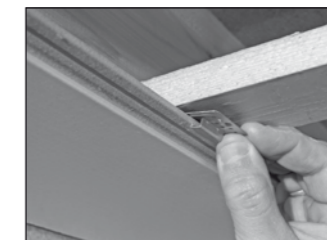
Befestigungskralle setzen
