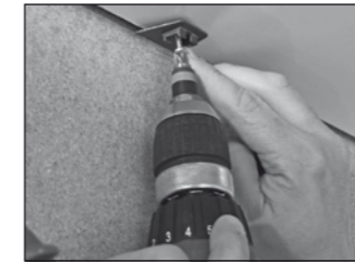
Leistenclip montieren
