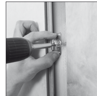
Mittelklammer setzen
