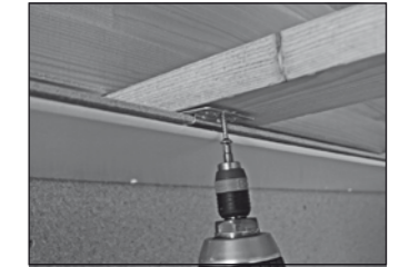
Befestigungskralle anschrauben
