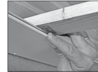
Befestigungskralle setzen
