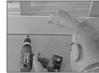
Erstes Steck-Paneel befestigen
