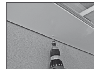
Erstes Steck-Paneel befestigen
