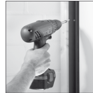
Befestigungsschiene setzen
