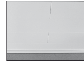
Deckenabschlussleisten aufstecken fertig
