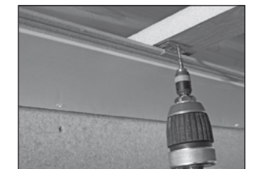
Befestigungskralle anschrauben
