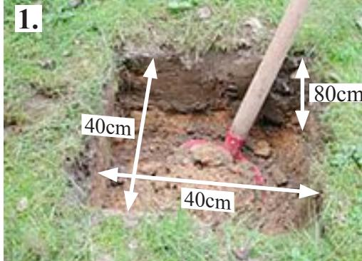
Eine Grube für jeden Pfosten ausheben.
