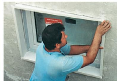
3. Zusammengesetztes Dämmungsanschlussprofil nach Abschluss der Wandbelagsarbeiten in die durch das Entfernen der Schalungsabdichtung freigewordene Nut einsetzen.
