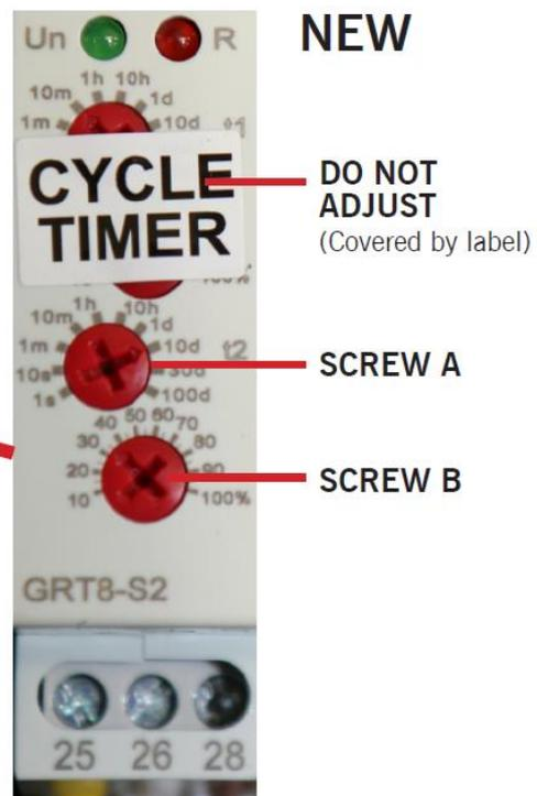
Blick in die Steuerbox: Obere Stellschrauben nicht verstellen! (von Etikett abgedeckt)
