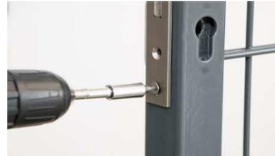
2. Montieren Sie den Profilzylinder.
