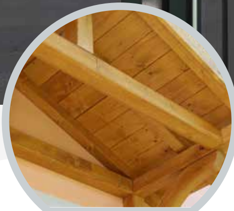
Stettin, Detailsicht Dachkonstruktion
