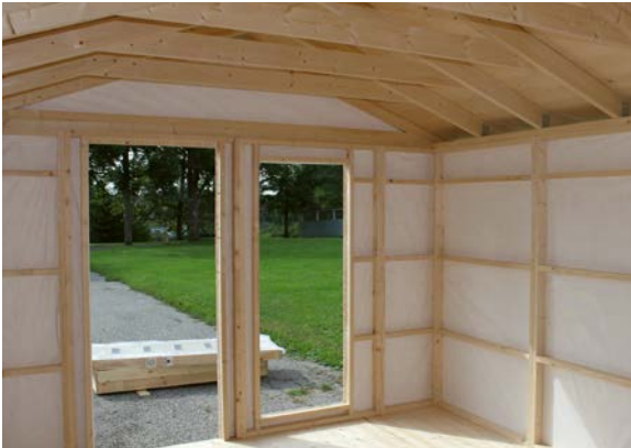
Innenansicht, Wände mit Windschutzfolie
