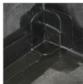
Innenecken-Abdichtung mit zwei versetzten FormFlash-Stücken
