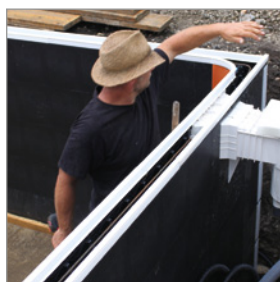
Schnellschalung mit Baustahl-Bewehrung und Rand-Abschlussleiste
