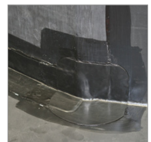
Auch radiale Beckenabdichtungen zuverlässig mit EPDM-Folie abdichten
