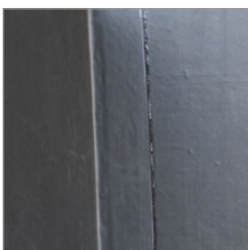
Spleißnahtverbindung zwischen zwei Folien
