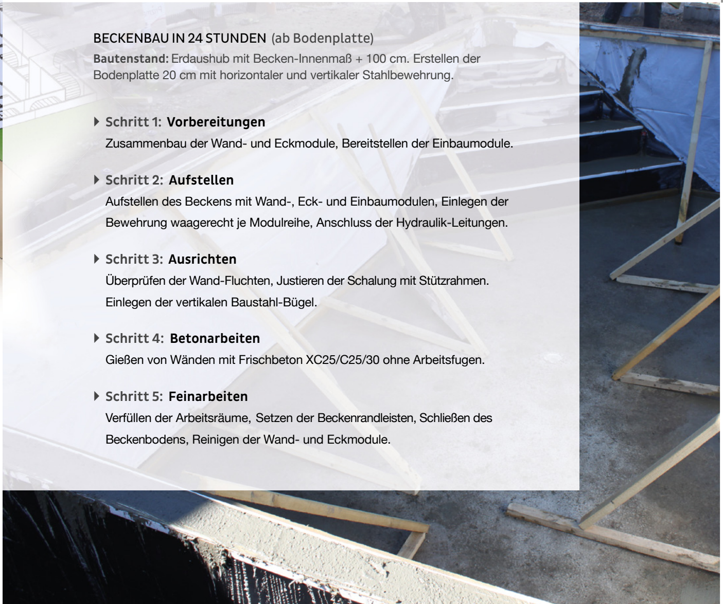
Aufstellen der Wand- und Eckelemente
