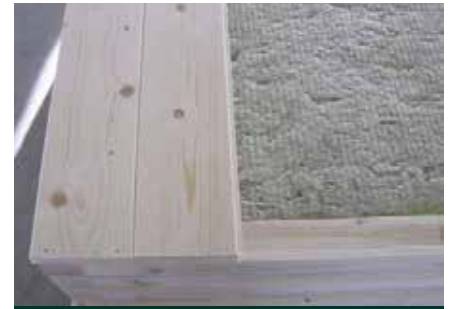
Gedämmte Zwischendecke im Saunaraum
