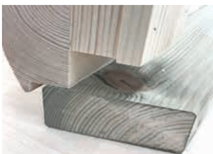
Wandelement auf imprägnierten Rahmen
