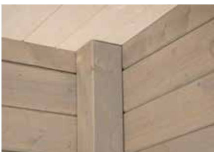
Eckpfosten aus Leimholz 90 x 90 mm
