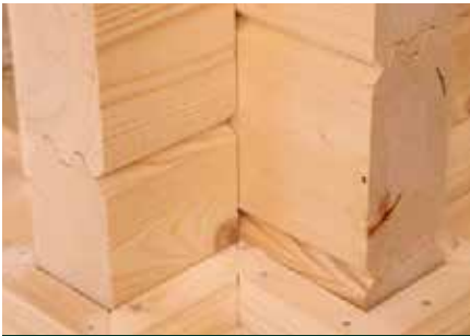
Eckverbindung 70-mm-Bohle
