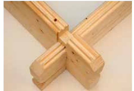
Eckversatz winddicht
