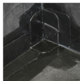
Innenecken-Abdichtung mit zwei versetzten FormFlash-Stücken
