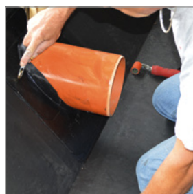
Abdichtungen von freiwinkligen Einläufen mit FormFlash möglich
