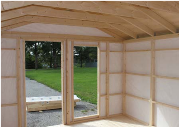
Innenansicht, Wände mit Windschutzfolie
