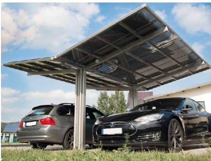
Doppelcarport mit Solarpaneelen
