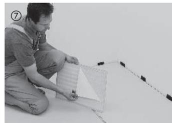
Beim ersten Element der dritten Reihe ist die Klebeschuttfolie vor der Verlegung zu entfernen. Die Klebeschuttfolie sollte dabei leicht schräg abgezogen werden, um ein Einreißen zu verhindern. Dann kann das Element mit Kunststofffedern links beginnend längsseitig in die bereits verlegten ersten Reihen eingedreht und abgesenkt werden. Anschließend das nächste Element ebenfalls von der Klebefolie befreien und eindrehen.
