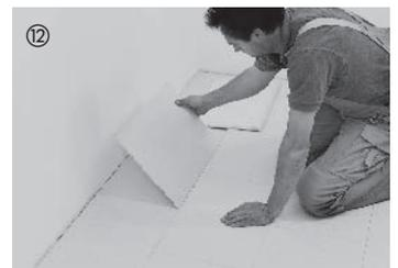
Nach Fertigstellung der Fläche sind die beiden ersten Reihen wieder zu entnehmen, und nach Entfernung der Klebeschuttfolie (siehe 7.) zu verlegen.
