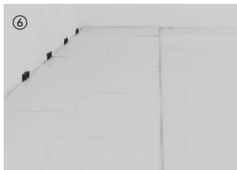
Vor Verlegung der weiteren Reihen muß unbedingt die exakte Flucht der ersten beiden bereits verlegten Reihen überprüft werden. Die korrekt ausgerichteten Reihen sind unbedingt im Randbereich mit Abstandskeilen zu fixieren. Bei Bedarf kann im Längskantenbereich leicht geklopft werden.
