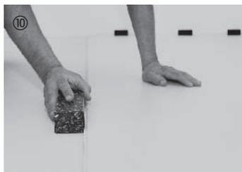
Nun kann im Längskantenbereich mit dem Schlagklotz leicht nachgeklopft werden. Tipp: Um die Verbindung zwischen Element und Unterkonstruktion zu stabilisieren, empfehlen wir die Fläche nach der Verlegung der jeweiligen Reihe zu begehen. So sind alle weiteren Reihen zu verlegen.
