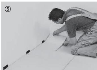
Das letzte Element der ersten Reihe wird unter Berücksichtigung des Dehnungsabstandes von 10 – 15 mm zur Wand zugeschnitten und eingefügt. Mit dem Reststück der ersten Reihe wird in der nächsten Reihe wieder begonnen (stirnseitiger Versatz von mindestens 18 cm). Dadurch wird der Verschnitt erheblich reduziert.
