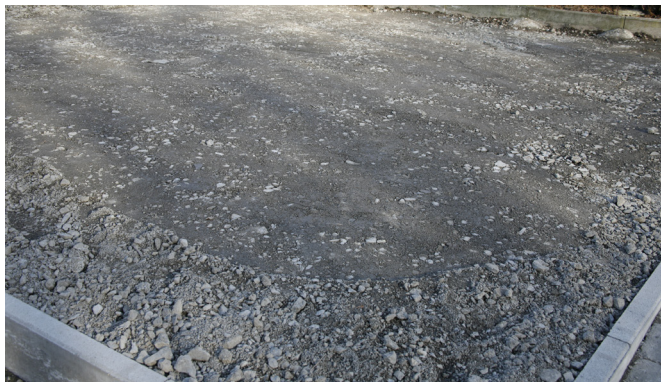
Verdichtetes Schotterbett mit Gehwegplatten als Minimaluntergrund für die Errichtung eines Hauses.
