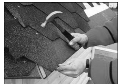
Achten Sie darauf, daß Sie seitlich genügend überlappen. An der Dachtraufe muß die Schindel bündig abschließen.
