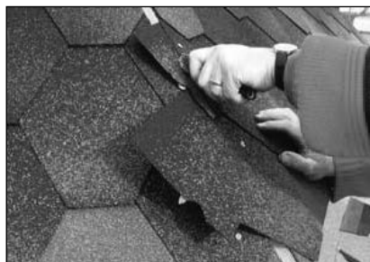
Die seitlichen Überstände werden nun mit dem Teppichmesser entlang dem Dachfalz bündig abgeschnitten.
