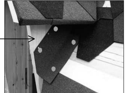
Schindel mit Dachpappnägeln befestigen
