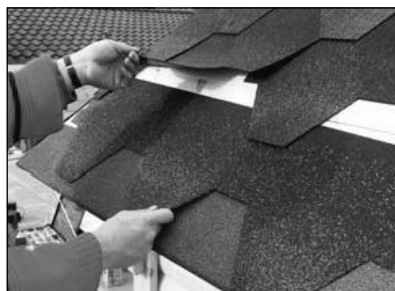
Schindel leicht anheben und nachfolgende darunter schieben und ausrichten.
