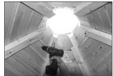
Dachhaube von innen mit Schrauben befestigen
