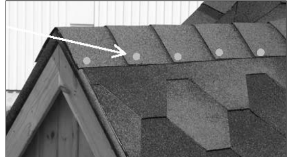
Schindel mit Dachpappennägel befestigen
