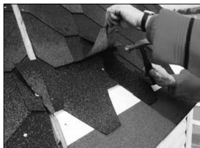
Befestigen Sie die Schindeln mit den mitgelieferten Dachpappnägeln. Sie benötigen pro Schindel 5 Nägel.
