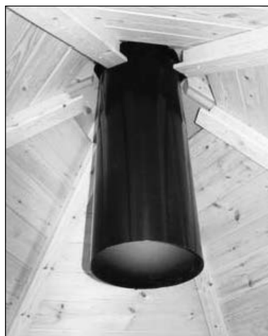
Innenansicht mit Kaminrohr
