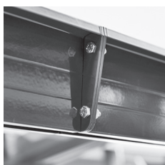
Pfettenverschraubung Edelstahl Schrauben/Muttern
