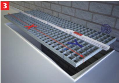
Ermitteln Sie die Breite des Gitterrostes (X-Maß). Ermitteln Sie die Tiefe des Gitterrostes und addieren Sie den Abstand zur Wand (Y-Maß). Anschließend können Sie die vier Profilstücke zusägen und den Rahmen zusammenstecken
