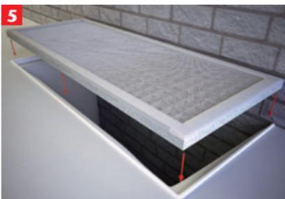
Befestigen Sie die Abdeckung am Gitterrost. Zum Abschluss montieren Sie den Rost wie im Ursprungszustand an Ihrem Kellerschacht.
