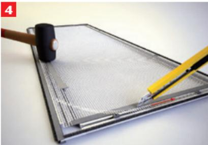
Führen Sie das Wandanschlussprofil in die vorgesehene Nut. Stecken Sie die umlaufenden Bürstendichtungen in die vorgesehene Nut. Richten Sie das Gewebe auf der Abdeckung aus. Fixieren Sie das Gewebe mittels des Einschlagkeder. Schneiden Sie das Gewebe rund um den Keder ab
