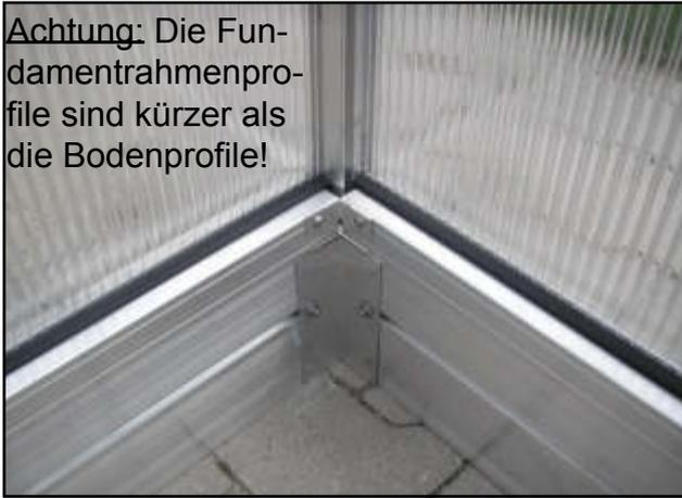
In die Fundamentrahmenprofile in den Ecken je eine Schraube M6 x 12 (S12) einziehen, Eckwinkel (V26) aufstecken und mit Mutter M6 (S1) verschrauben.
