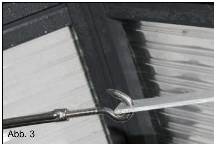
Die Haken des Spannschlusses werden beidseitig durch die Bohrungen der Aluminium-Flachprofile eingefädelt.
