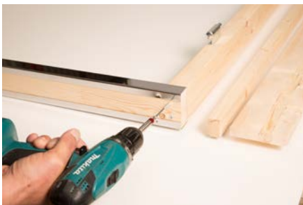
4. Anschrauben der unteren Türschwelle
