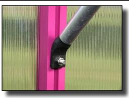
Tisch/Borte an den Gewächshaussprossen verschrauben. Hierzu die Streben (Pos. 3) und die Winkel (V185) an den Sprossen mit Hilfe der Hammerkopfschrauben M6 x 16 (S15) anschrauben.
