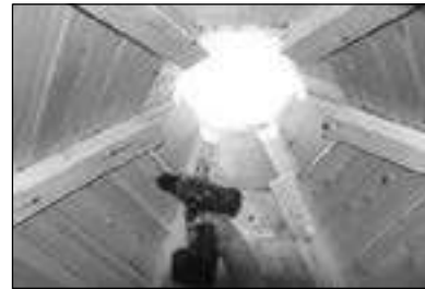
Dachhaube von innen mit Schrauben befestigen
